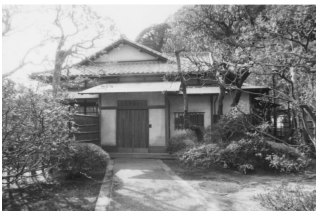
建物玄関周辺
