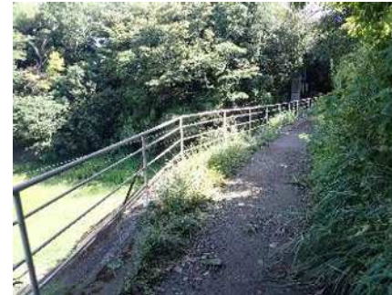
ガードパイプ
