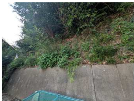
急傾斜地箇所⑤
