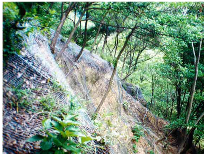
落石防止工 (イメージ写真)
