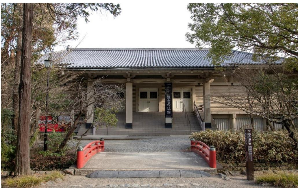
登録有形文化財に登録される当館の本館は、鉄筋コンクリート造による高床式の校倉風建築です。設計は日本銀行小樽支店や歌舞伎座(第三期)の設計で知られる岡田信一郎、施工は松井建設(当時松井組)でした。外観を奈良の正倉院に模し、内部は鎌倉時代の寺院建築の手法が用いられています。寄棟瓦葺き屋根の中央部には、小屋裏位置に採光用の越屋根を隠したり、さらに内部では虹梁大瓶束形式で採光用越屋根の棟を支える造りとされています。
