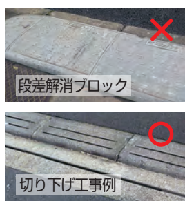
段差解消ブロック(左)と切り下げ工事例(右)
