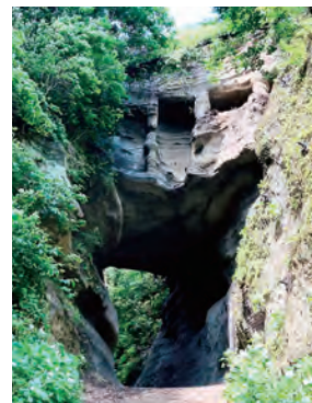
工事完了後の状況(大町側)
