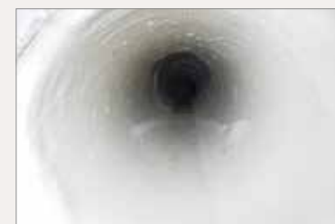
修繕された後の下水道管
