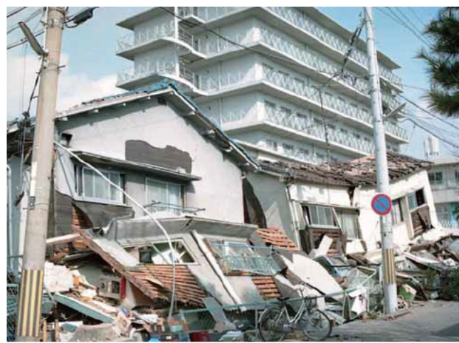
写真上：倒壊した建物によってふさがれた道路 左下：倒壊した住宅とそれに押されて崩れたブロック塀 右下：倒壊した住宅と、倒壊を免れた共同住宅 いずれも阪神・淡路大震災の被害状況
