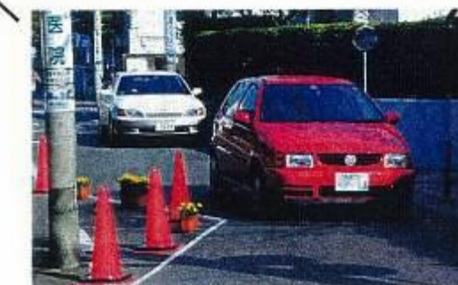
区間③：電柱を利用した狭さによる速度抑制
