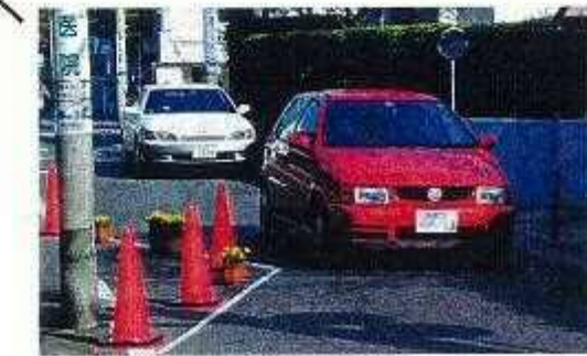
区間③:電柱を利用した狭さによる速度抑制
