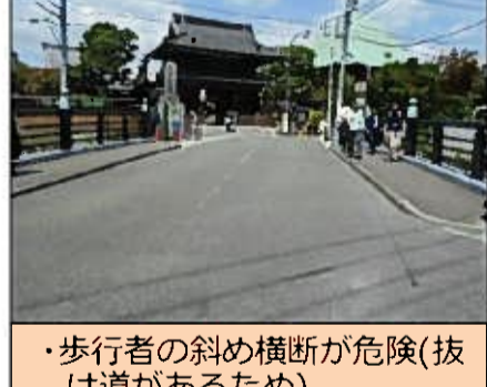
・歩行者の斜め横断が危険(抜け道があるため) ・橋のS字になっている箇所は車の見通しが悪い、ガードレールがあるため余計に道幅が狭い
