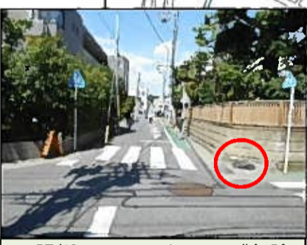
・隅切においてある石が危険である
