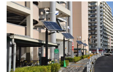
再生可能エネルギー（ソーラーと風力）を活用したLED街路灯の例（曳舟）
