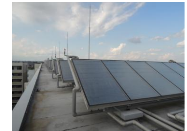
太陽熱温水パネル設置例 (越谷レイクタウン)
