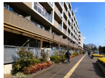
壁面後退部に植栽空間を設け、かつベランダからの出入りが可能な開放的なづくりの例 (さいたま市北部拠点宮原地区)
