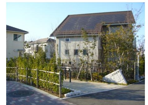
太陽光パネル設置住宅の例（越谷レイクタウン）
