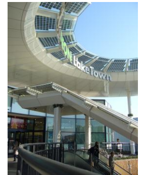
太陽光パネルの電力でエスカレータを動かしている例（イオンレイクタウン）
