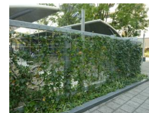
緑化フェンスで駐輪場を囲っている例（汐留ビルディング）
