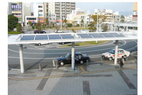
タクシーシェルターに太陽光パネルが設置されている例 (沼津駅)
