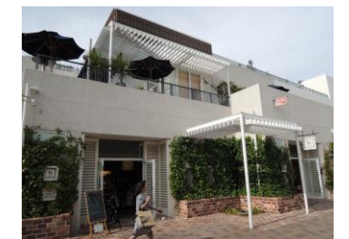
壁面緑化の例 (藤沢市)
