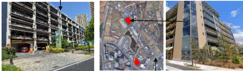
大型駐車場の相互利用（柏市）
