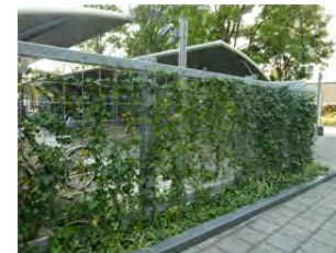
緑化フェンスで駐車場を囲っている例（汐留ビルディング）
