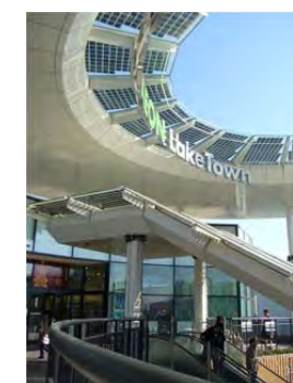
太陽光パネルの電力でエスカレータを動かしている例（イオンレイクタウン）
