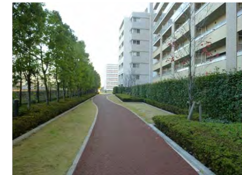
遮熱性舗装の例（足立区ハートアイランド新田）
