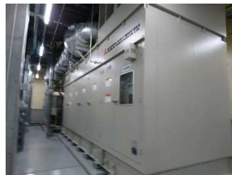
コージェネレーションシステム
