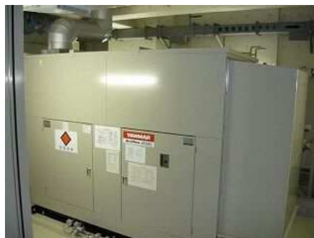
非常用発電機
