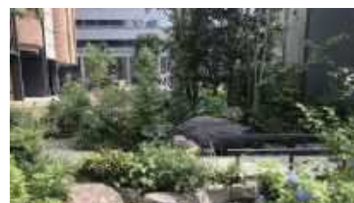
レインガーデン（雨庭）： 降雨時に雨水を一時的に貯留し、時間をかけて地下へ浸透させる透水型の植栽スペース
