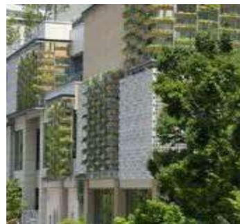
自然素材を生かした建築物壁面（横浜市）
