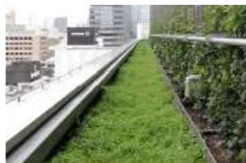
屋上・壁面緑化
