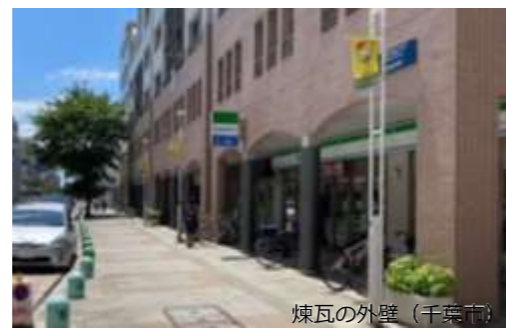
煉瓦の外壁（千葉県）
