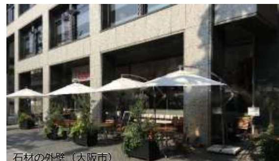
石材の外壁（大阪市）
