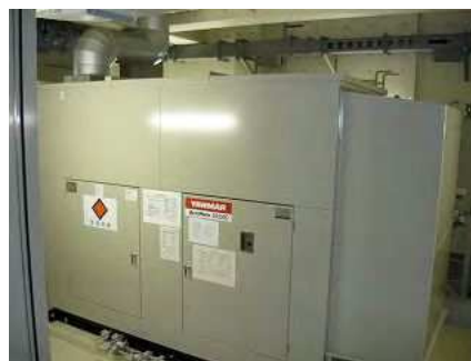
非常用発電機のイメージ
