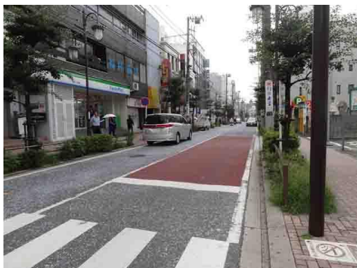
←車の停止線の前にカラー舗装を施し、運転手からの交差点部の明示性を高めました。
