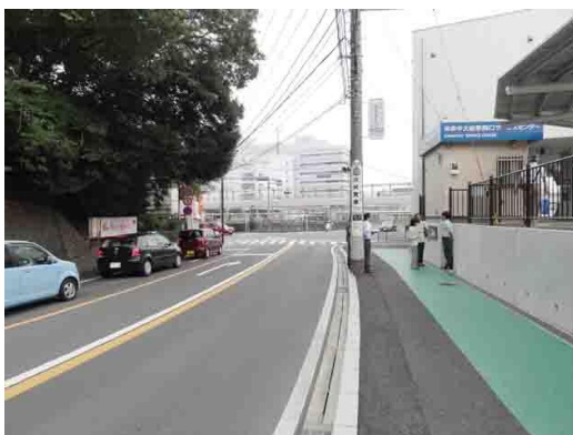
←円滑な交通処理のための車の右折レーンを整備しました。
