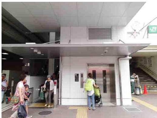
←エレベーターとエスカレーターを整備し、バリアフリー化を図りました。
