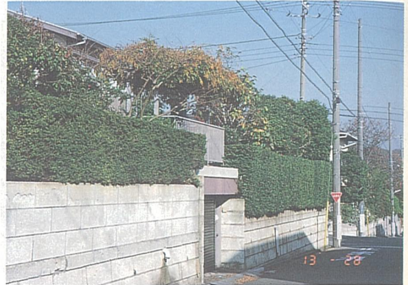
石積み、擁壁に対する緑化を図り、圧迫感を和らげる
