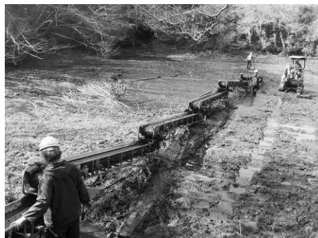
鎌倉中央公園拡大区域(台峯)で行われたため池の浚渫工事
