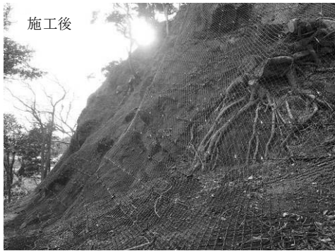
落石を防ぐために落石防止網が張られた雪ノ下の斜面 (写真提供：神奈川県横須賀三浦地域県政総合センター地域農政推進課)
