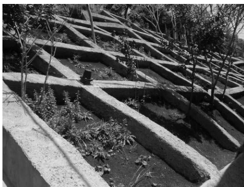
稲村ガ崎三丁目で施工された急傾斜地崩壊防止工事 (写真提供：神奈川県藤沢土木事務所河川砂防第二課)
