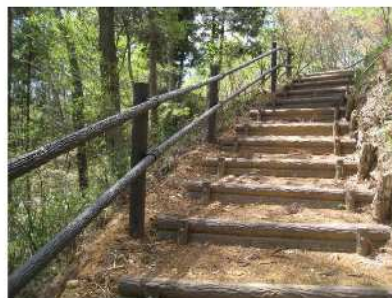
階段・転落防止柵イメージ（擬木製）
