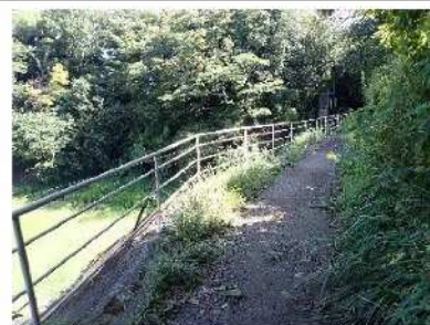
ガードパイプ
