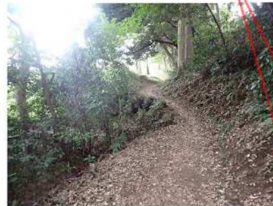
転落防止柵設置が必要な箇所の例
