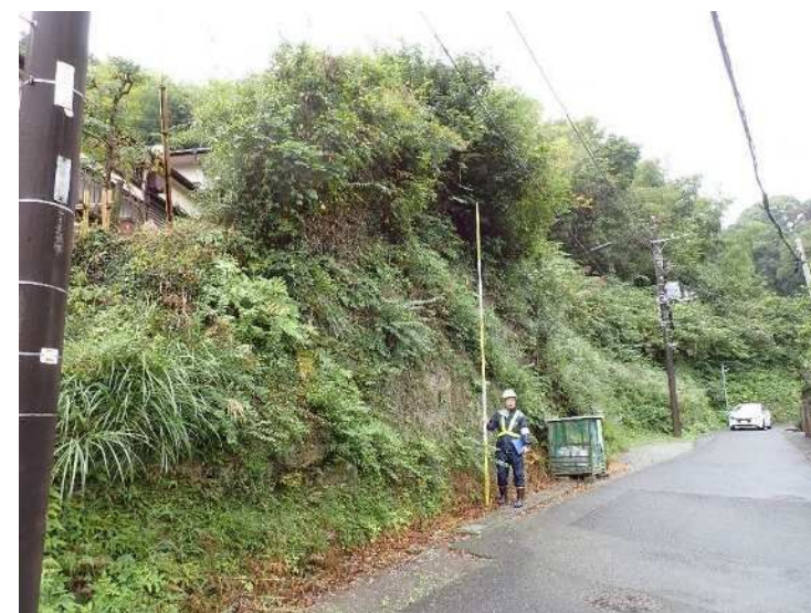
露頭(2) 道路側方の急勾配のり面
