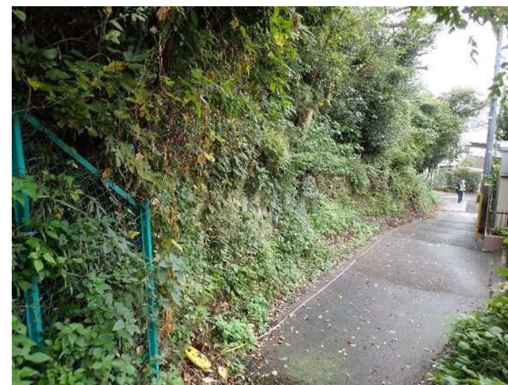
露頭(3)南側より 道路側方の急勾配のり面
