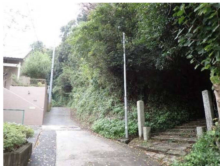
露頭(3)北側より 道路側方の急勾配のり面
