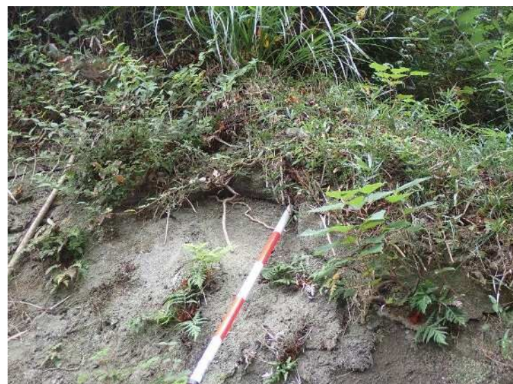
露頭(2)拡大図 剥落跡
