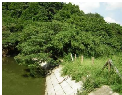
■東側道路より上池の堤を望む
