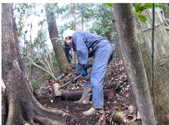
階段の設置の様子
