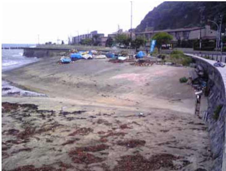
船揚場（斜路）整備（坂ノ下地区）
