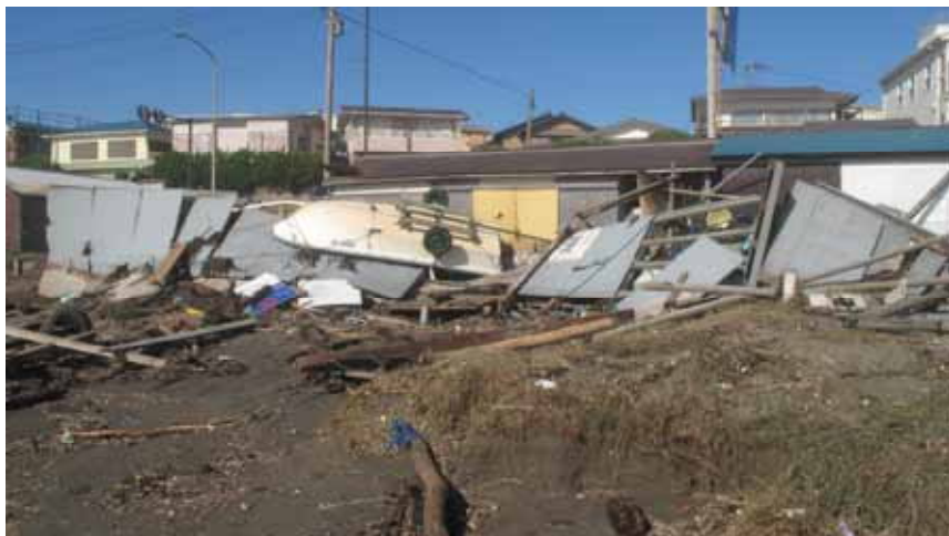
浜小屋及び漁船の損壊（平成 21 年 10 月：台風 18 号）
