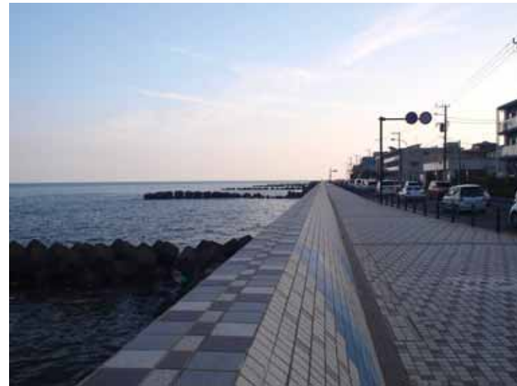
鎌倉海浜公園（坂ノ下地区）地先の護岸と突堤群
