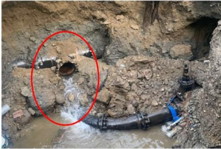
(図2 漏水箇所写真)
