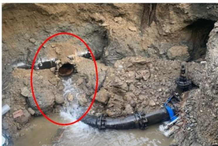
(図2 漏水箇所写真)
