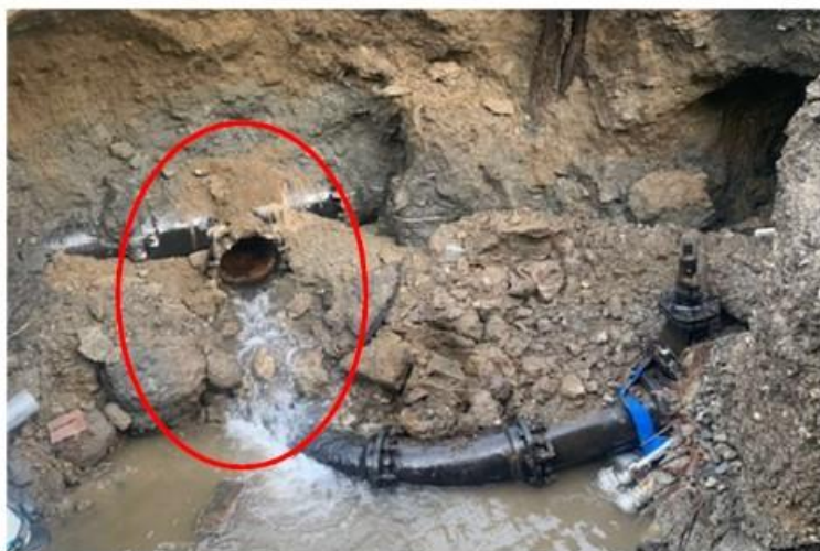
(図2 漏水箇所写真)
