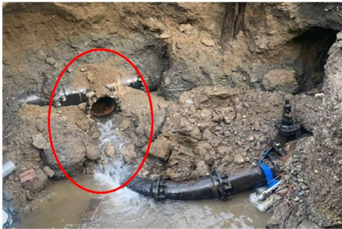
(図2 漏水箇所写真)
