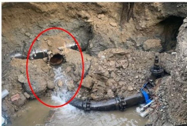
(図2 漏水箇所写真)
