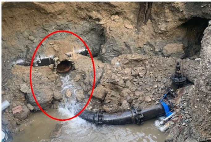
(図2 漏水箇所写真)
