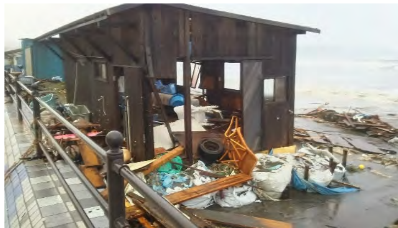
平成29年10月、台風21号によって発生した漁具倉庫被害
