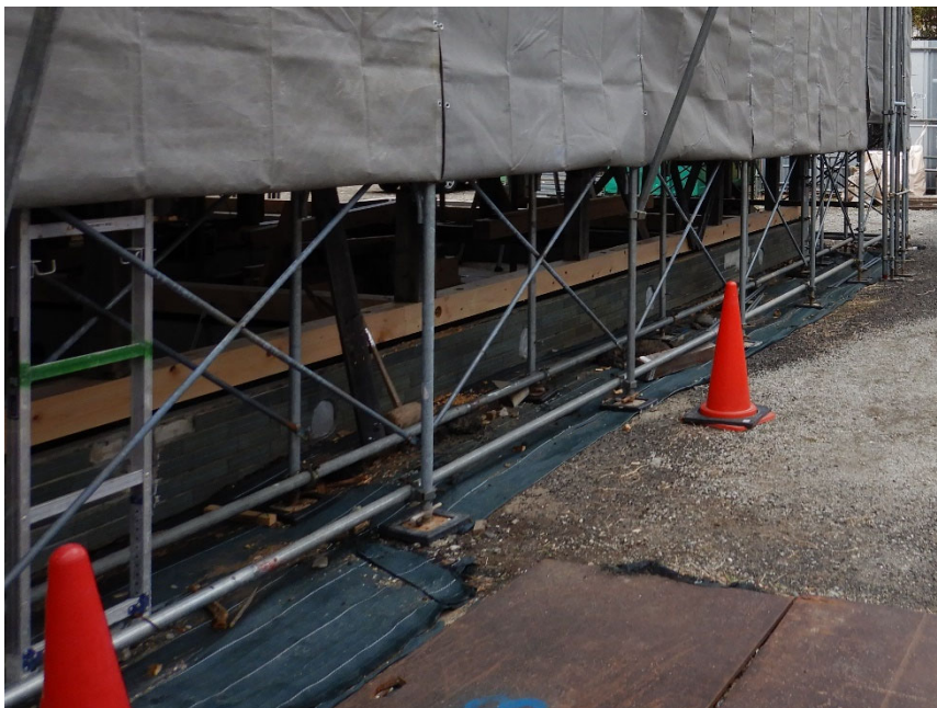
令和4年2月 腐朽していた土台 (外周部)の交換
