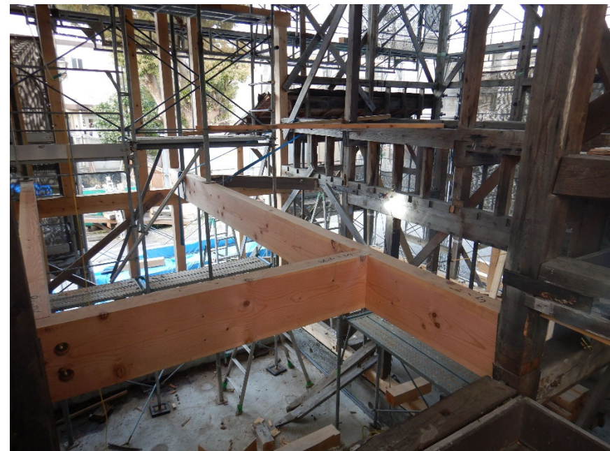
令和4年2月 腐朽していた土台 (外周部)の交換
