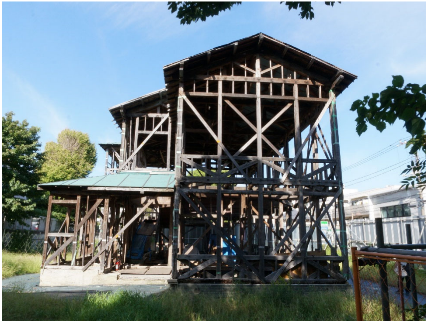
令和3年10月 工事再開時の様子 (御成小学校側)
