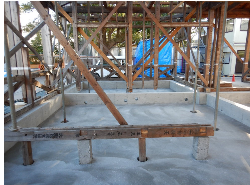
令和4年1月 耐震補強のため 既存基礎の内側に 基礎を増し打ち
