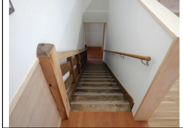
⑨子ども室 2 小屋組み(存置)
