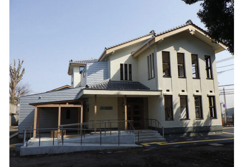
道路側の外観（東側）
