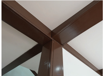
④図書室 箱目地下見板張(交換)
