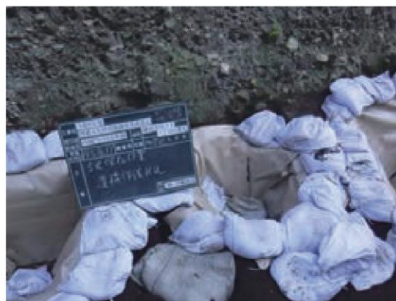
大型柱穴養生状況
