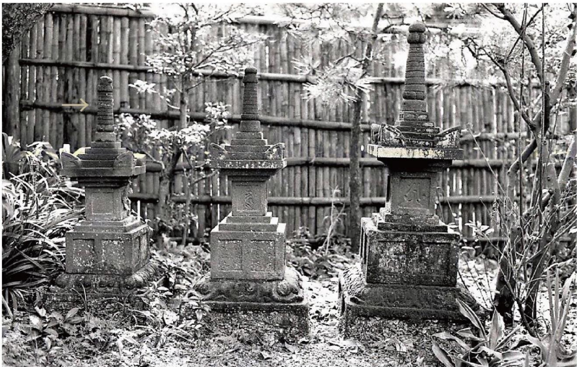
図4 昭和57年10月11日調査時の状況（佐藤 Web から転載） 本塔（3号塔）は左。相輪に修復痕がある（矢印）。
