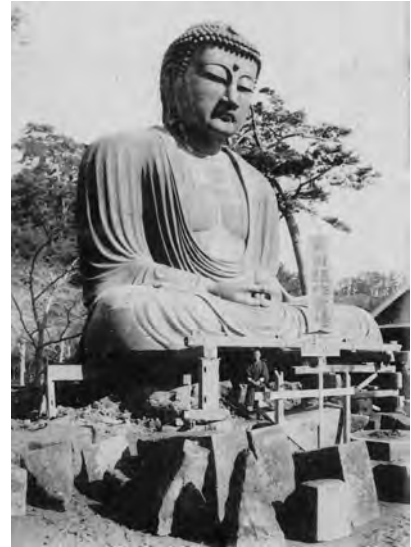
図 24. 大仏台座の解体状況
