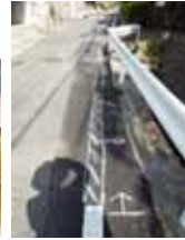
▲ガスマンの工事中
