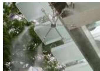
図 7.5.4-3 ミストのノズル(くもがたノズルの例)
