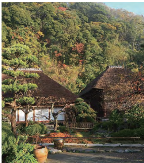
茅葺きの屋根が、周りの谷戸の緑となじむ
