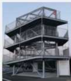
津波避難タワー
