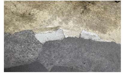
↑ 深沢支所執務室内床
