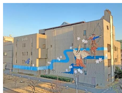
浄化センター
