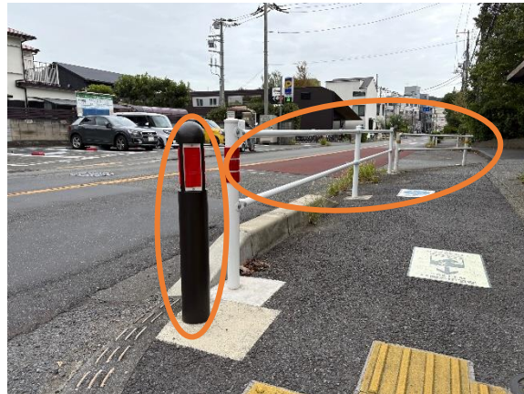
図 2-83 ガードパイプ（写真奥側）と車止め（写真手前側）の例
