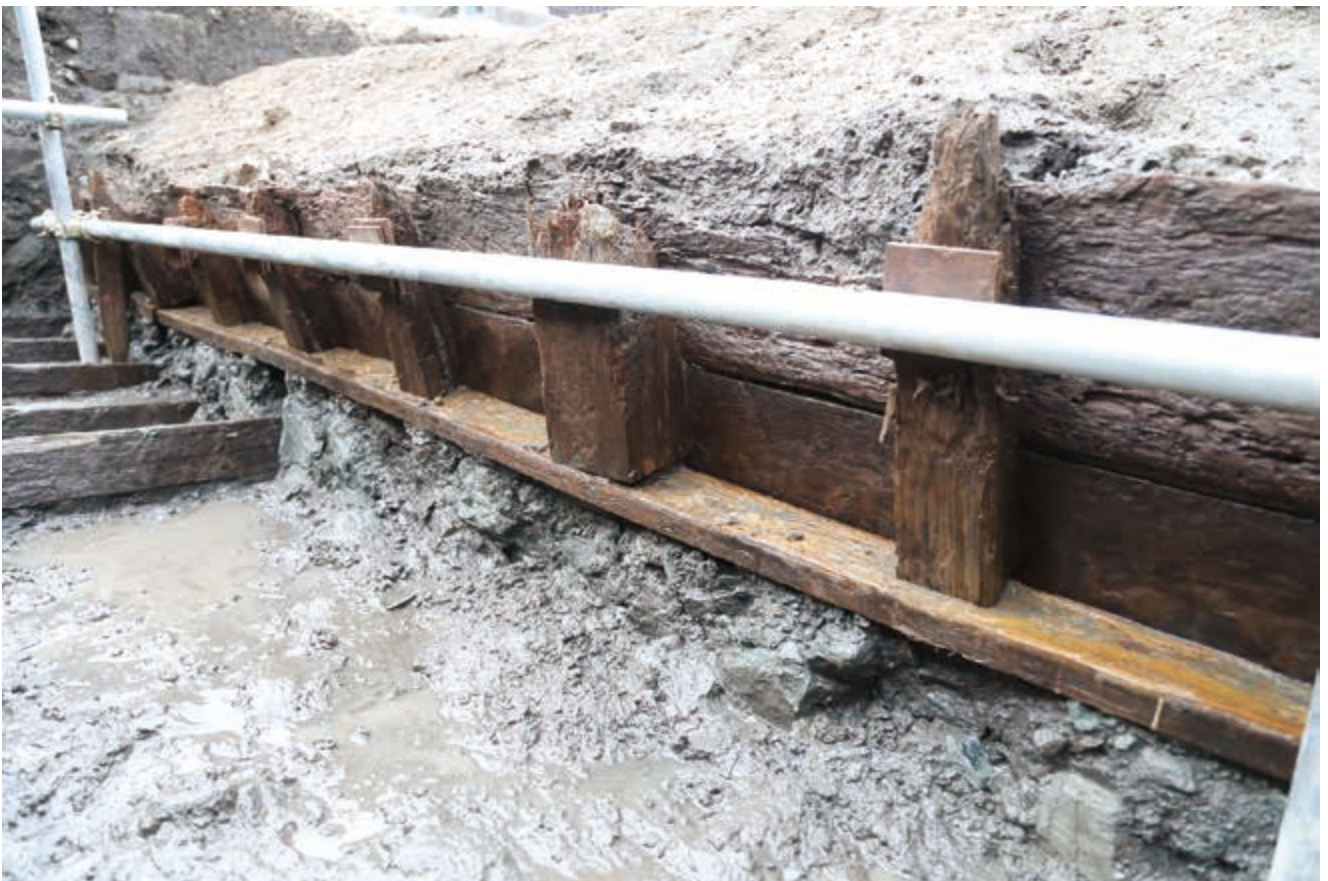
写真1 鎌倉時代後期の山ノ内道側溝の木組み護岸
