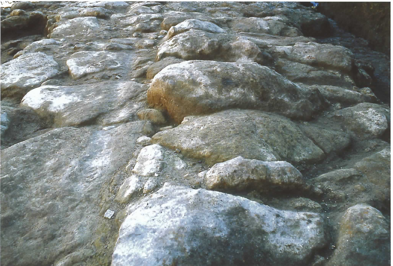
写真8 道路に残された わだち 轍の跡 (Photo 8) Rut
