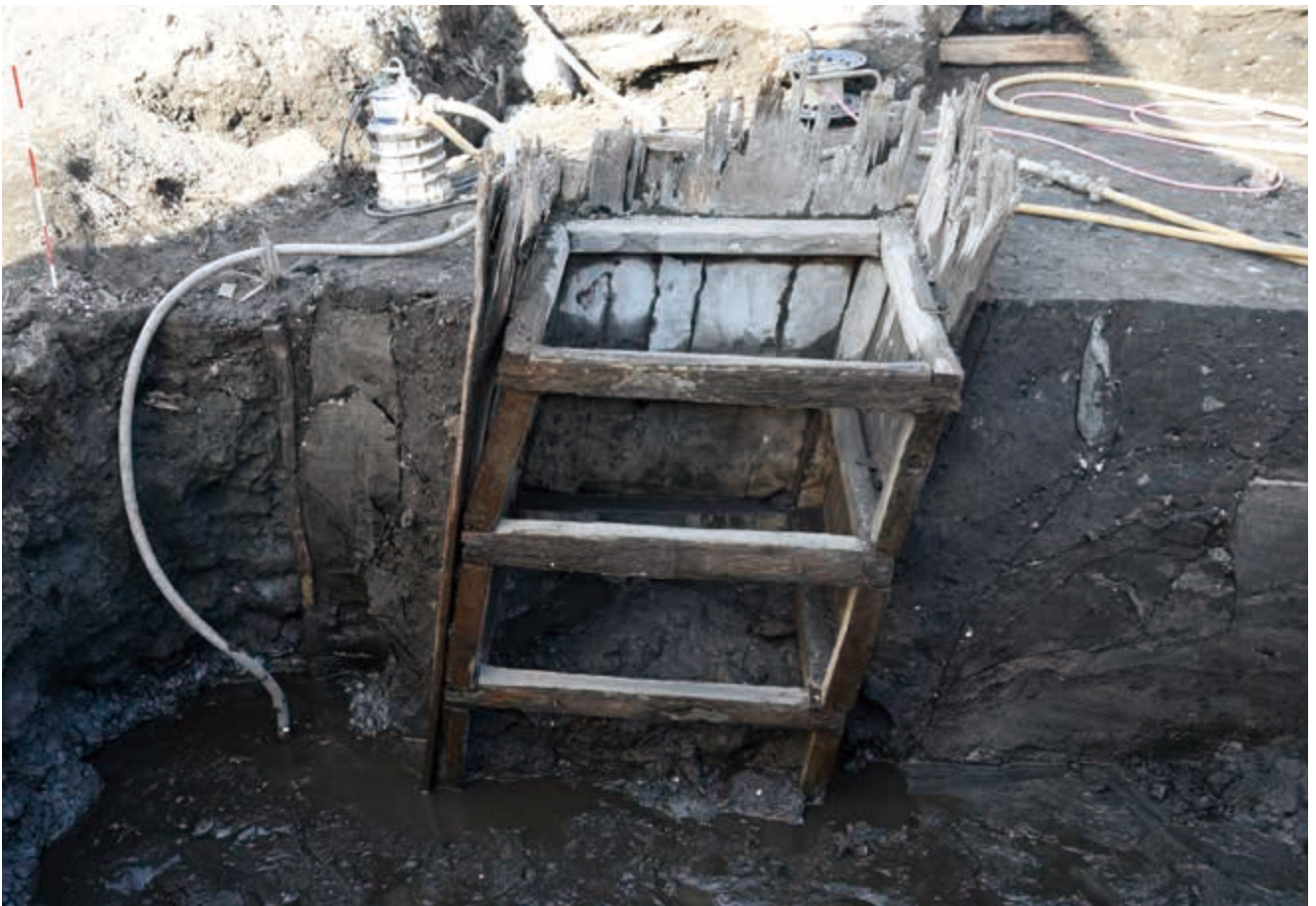
写真11 傾いた井戸 (photo11) Slanting well
