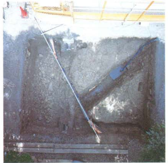
平成12年度 2区 大仏殿礎石下の根固め
