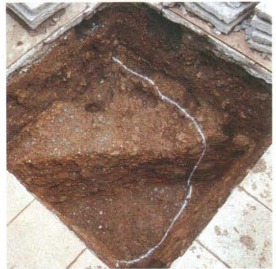
平成13年度 3区 大仏殿礎石下の根固め
